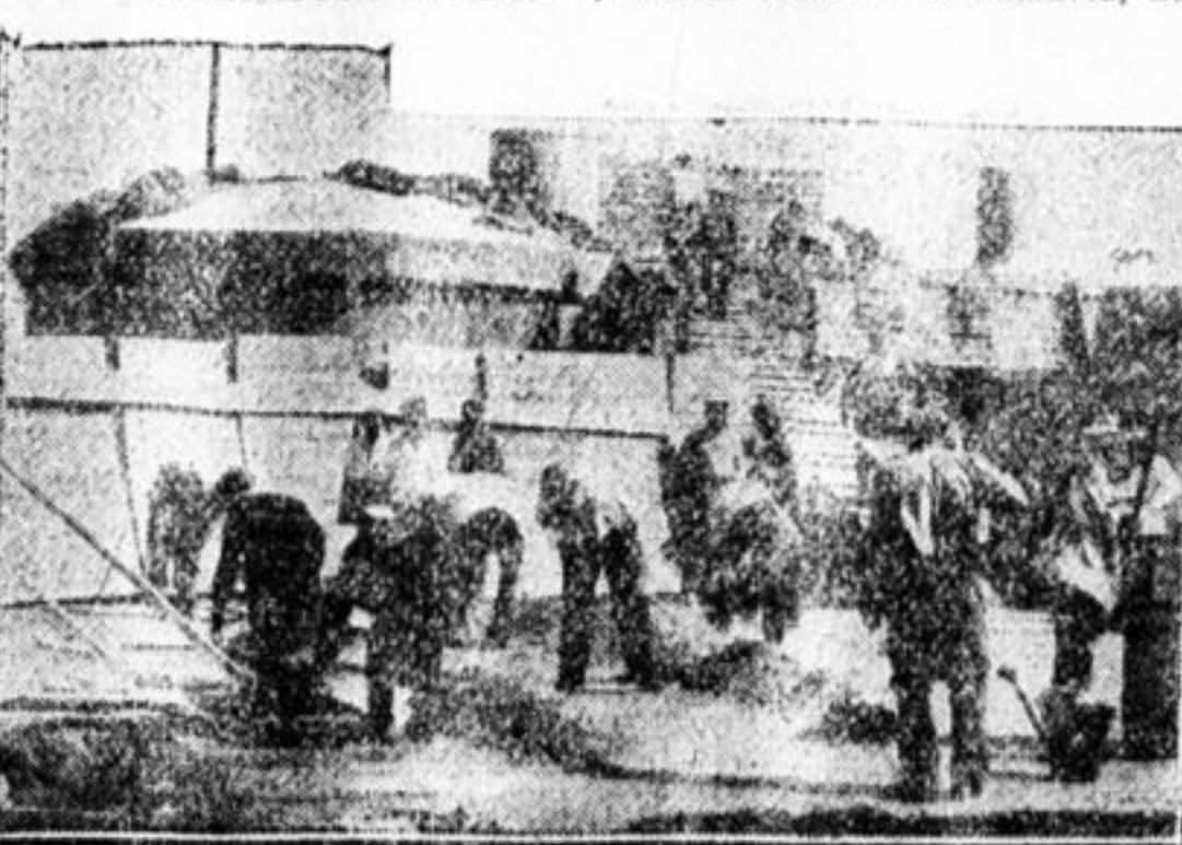
Постройка городского водопровода в Ставрополе. Водохранилище с распределительной камерой (объем 500 куб. метров).
